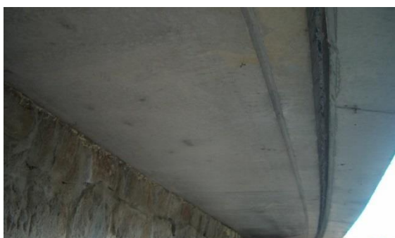
Obr. 5 Vyložení desky, rozšiřující most:
