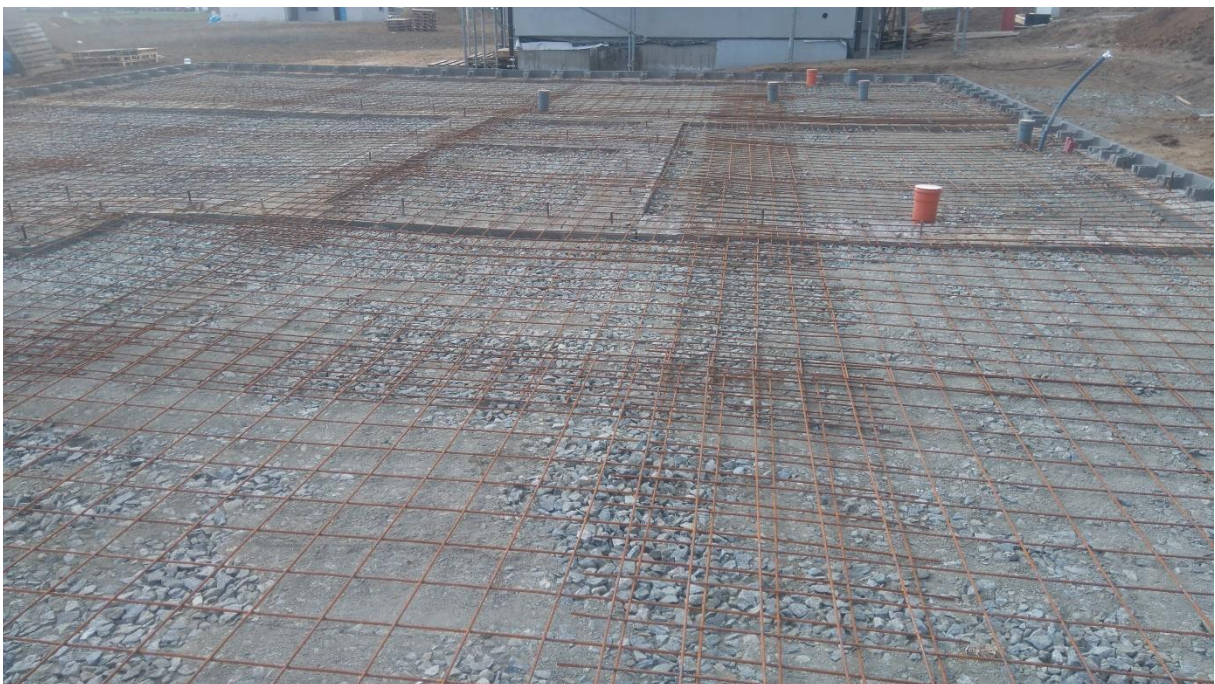
Obrázek 5.: Pohled na budoucí základovou desku po položení sítí Kari. Sít' není podložena, prováděcí firma prohlásila, že podložení bylo následně provedeno.
