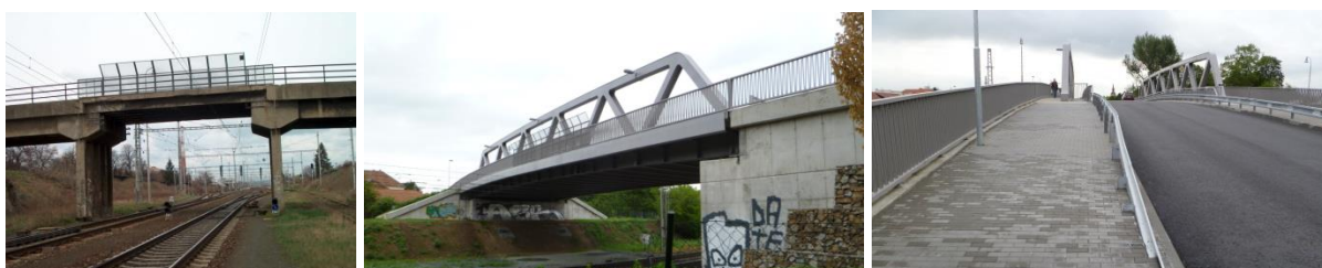
Obr.86:Úzký, dožilý žlb. nadjezd Obr.87: Ocelobeton, Protasův nosník
