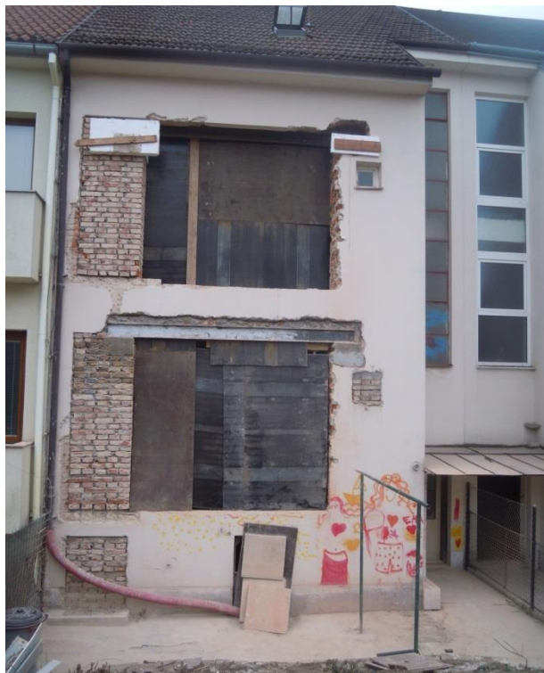
Obrázek 6.: Nové okenní otvory ve dvorní části. ↑
