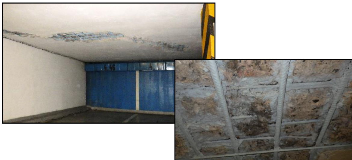
Obr.5: Příklad velké poruchy v místě smršťovací trhliny na rohu stropní desky s detailem „sanace“
