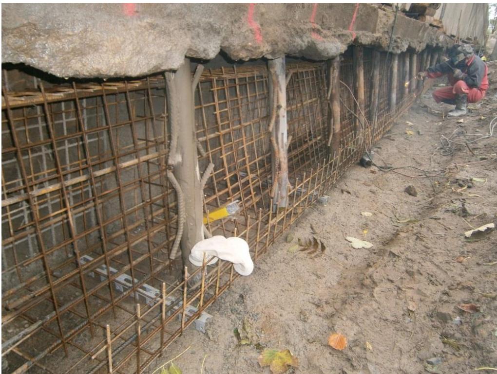
Obrázek 3.: Provádění zajištění základové spáry
