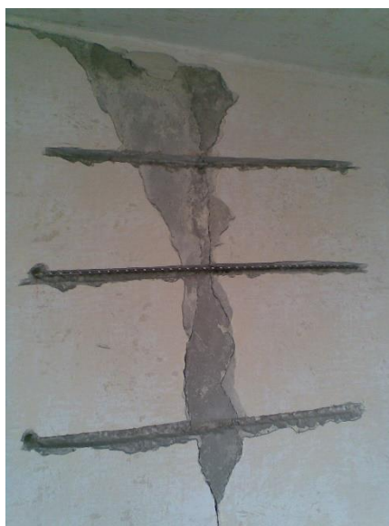
Obrázek 3.: Výztuž vkládaná do drážky – spoj panelů
