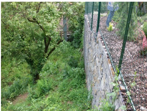
Obrázek 7.: Zeď postavená kolmo na spádnicí, deformace vzdušného líce zdi.
