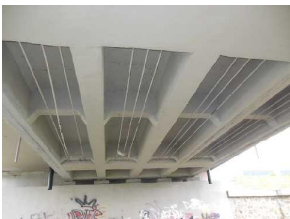
Obr.55:Externí předpětí trámové kce - lana Monostrand
