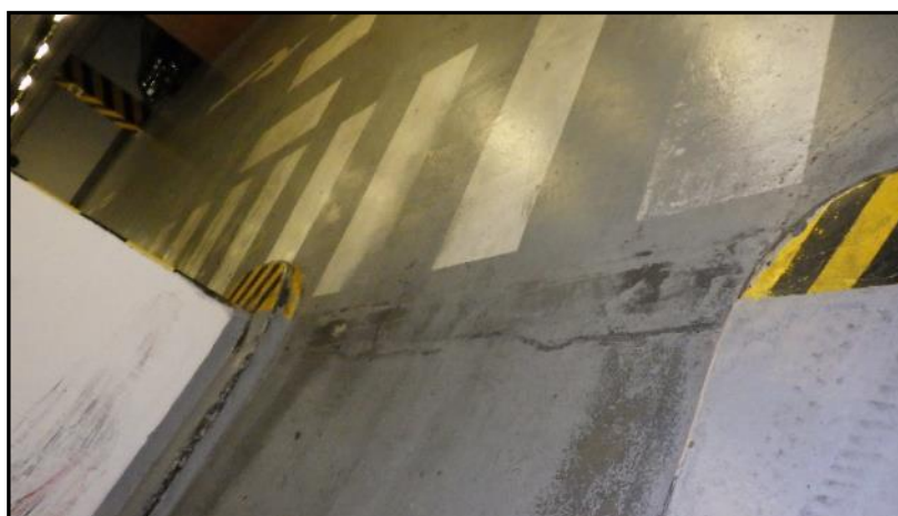
Obr.5: Příklad velké poruchy v místě smršťovací trhliny na rohu stropní desky s detailem „sanace“
