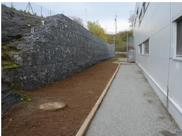
Obrázek 2.: Pohled na opěrnou gabionovou stěnu, za zdí vlevo frekventovaná silnice, vpravo výrobní hala, před zdí zelený pás.
