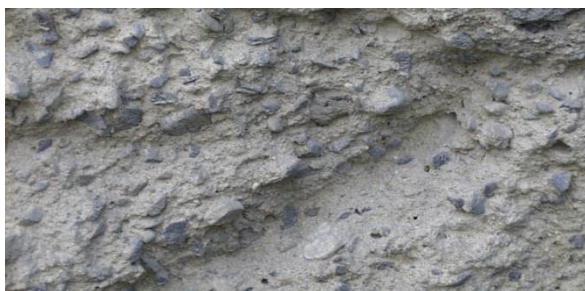
Obr.33: Povrch po otryskání VVP
