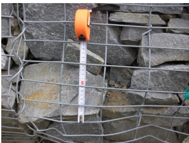
Obrázek 4.: Vyboulení zdi, potrhání dráty, použitý kámen a výplň.
