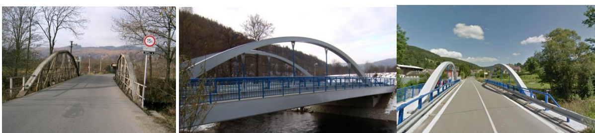
Obr. 74: Ocelový Langerův trám Obr. 75: Ocelobetonový „Langer“ Obr. 76: Pohled po vozovce
