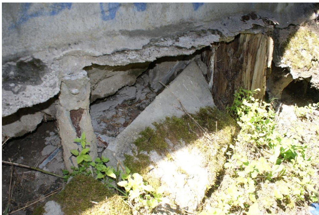
Obrázek 1.: Původní stav konstrukce, poškozený základ
