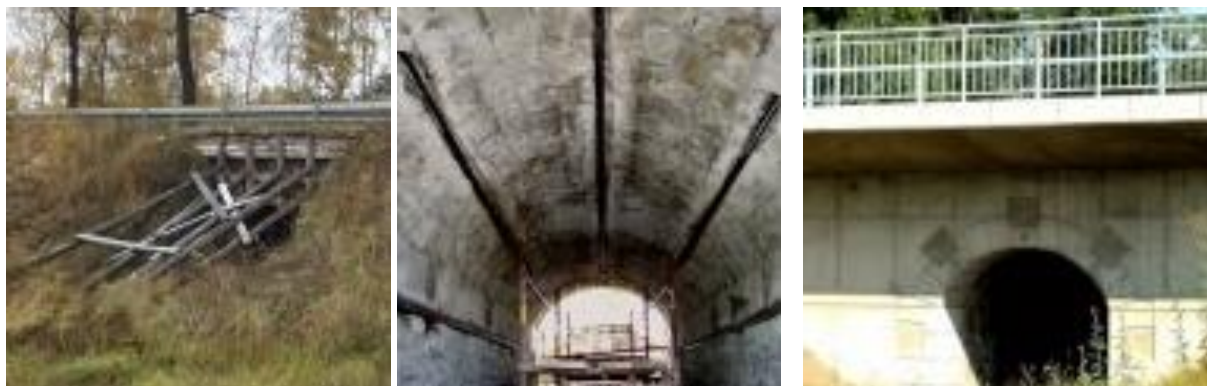
Obr. 7: Most před rekonstrukcí Obr. 8: Kabely příčného předpětí Obr. 9: Most po přestavbě
