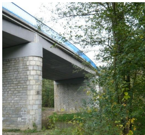
Obr. 44: Bok a pohled po sanaci
