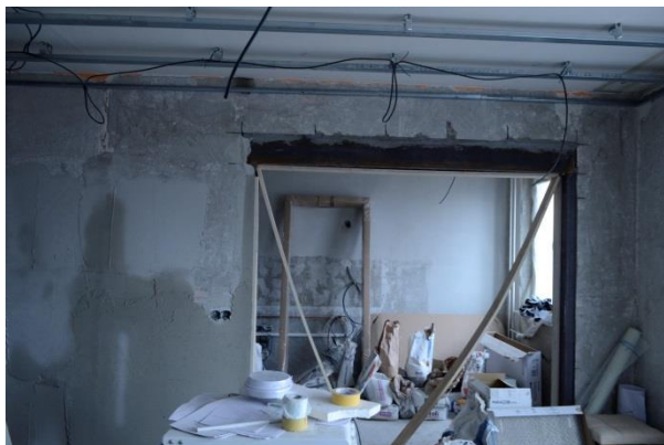
Obrázek 2.: Úprava nového otvoru
