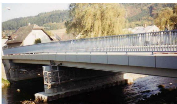
Obr.63: Místo nosníků MPD ocelobetonová konstrukce
