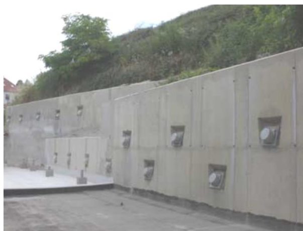
Obrázek 10.: Představení nové železobetonové zdi ukotvené zemními kotvami.
