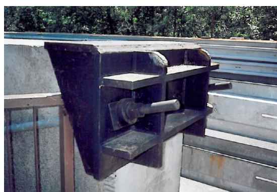
Obr. 58: Kotvení tyčí v čele parapetu
