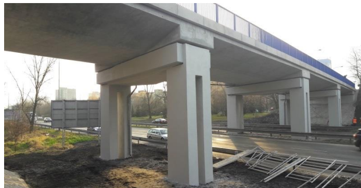
Obr. 60: Nová NK - předpjatá spojitá betonová deska
