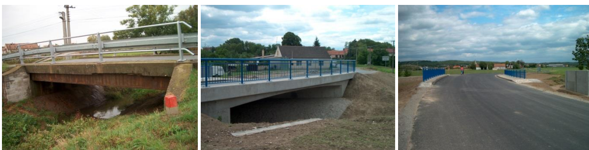
Obr. 68: Silná koroze NK, profily I+trubky Obr. 69: Rám s parabolickými náběhy Obr. 70: Pohled po vozovce
