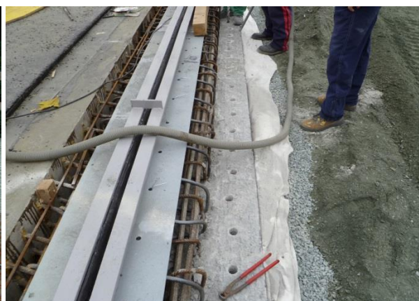
Obr. 40: Instalace mostního závěru
