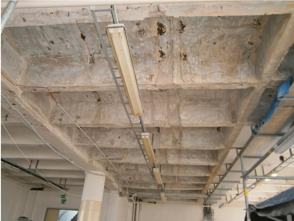
Obrázek 1.: Konstrukce po mechanickém očištění
