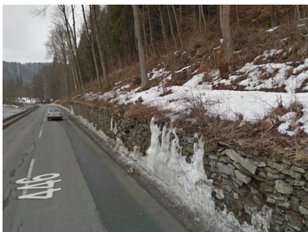
Obr.31: Původní stav zárubní zdí
