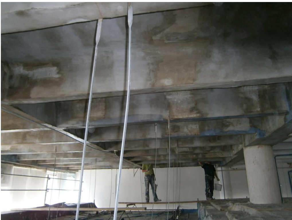
Obrázek 2.: Konstrukce při provedení hrubé reprofilace
