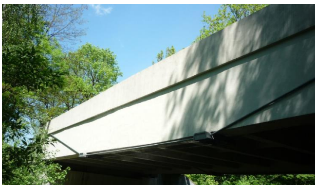
Obr.57: Zvýšení zatížitelnosti-externí předpínací tyče
