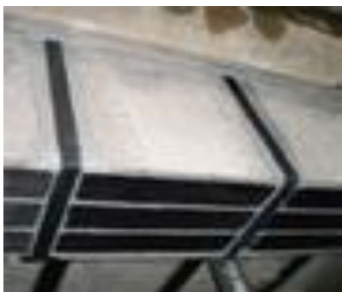
Obr.53: Uhlíkové lepené lamely na beton. trámu
