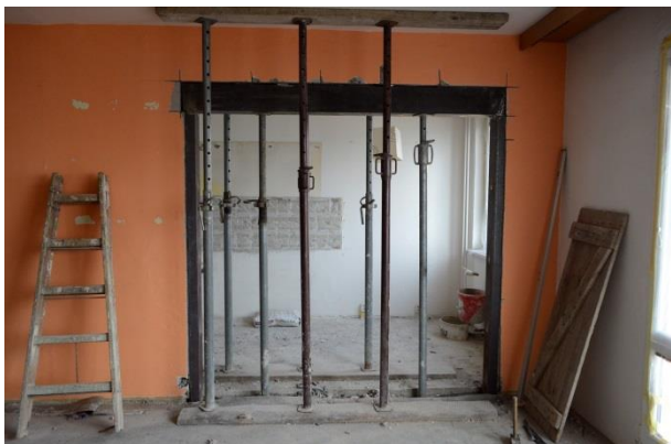
Obrázek 1.: Vyřezání otvoru a podepření stropu
