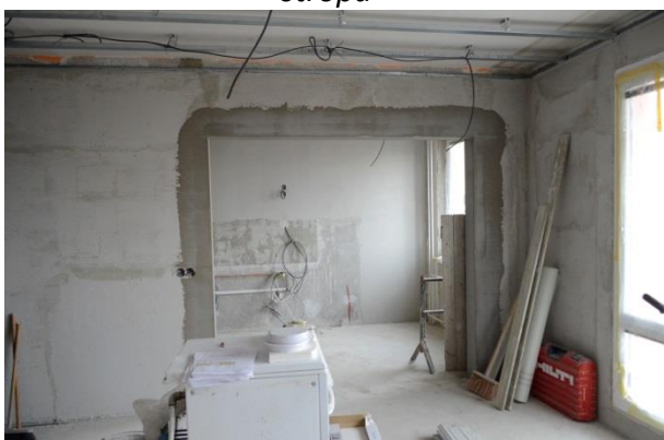
Obrázek 3.: Stavební práce na ostění otvoru
