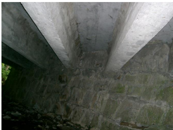
Obr. 1: Kamenná opěra železobetonové trámy
