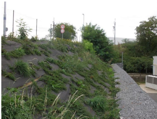
Obrázek 3.: Svah za zdí, povrch kryt fólií.
