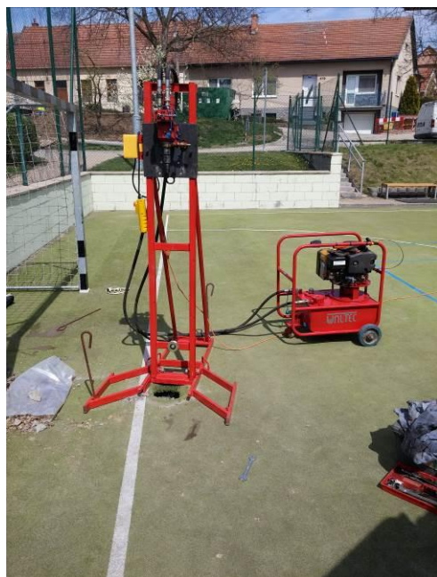
Obrázek 2: Pohled na vrtnou soupravu hloubící vrt J2
