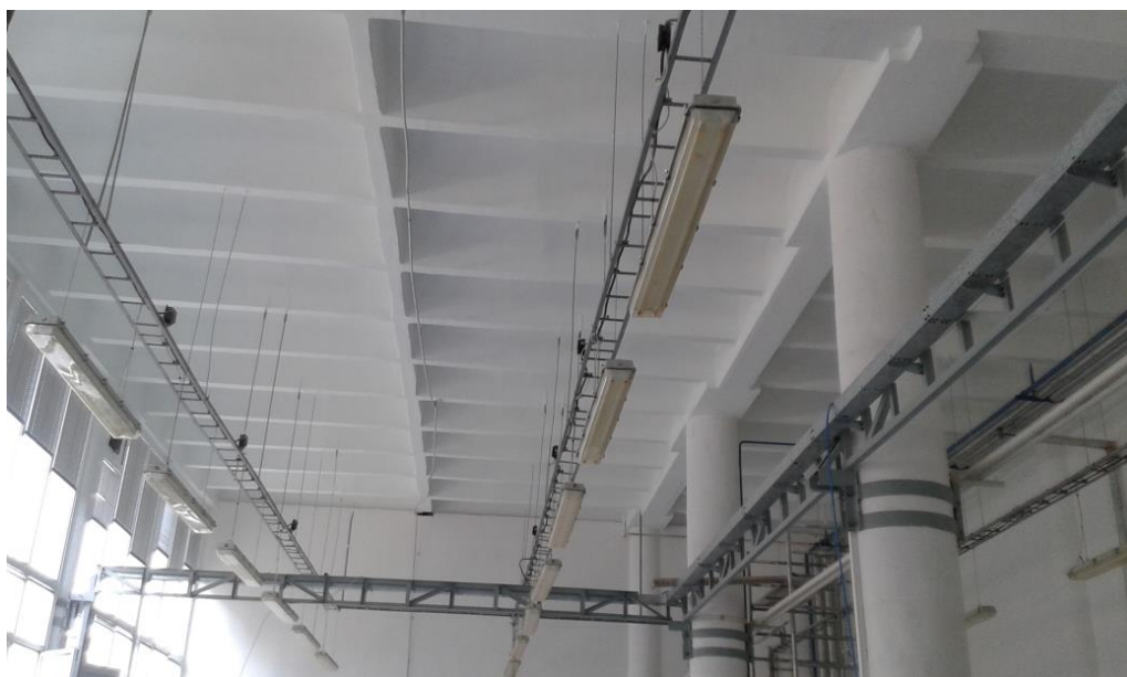
Obrázek 3.: Konstrukce po provedení sanace
