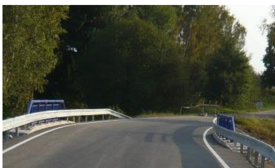
Obr. 6: Pohled na rozšířený most
