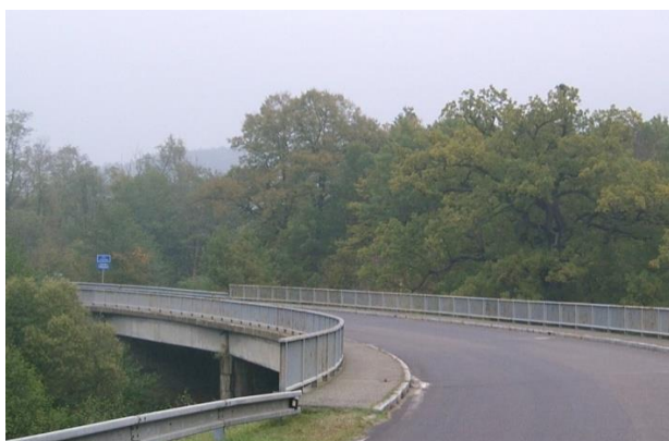
Obr.37: Stav mostu před sanací
