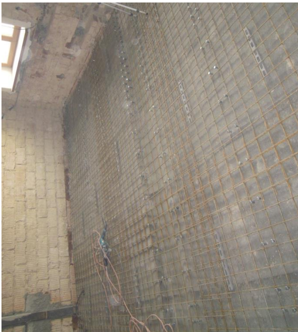
Obrázek 8.: Strop nad 1.NP před spřažením – spřahovací vruty s KARI sítí. ←
