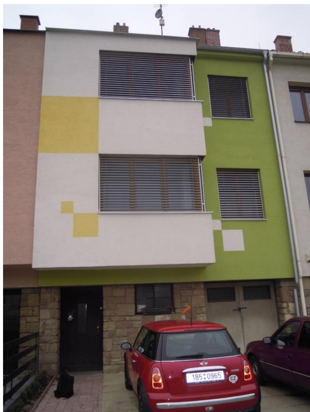
Obrázek 1.: Pohled z ulice na dům před rekonstrukcí. ↑
