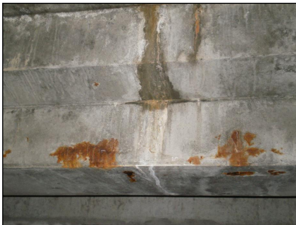
Obr.10 Příklad stavu nosné konstrukce – prefabrikovaných průvlaků pod stropem
