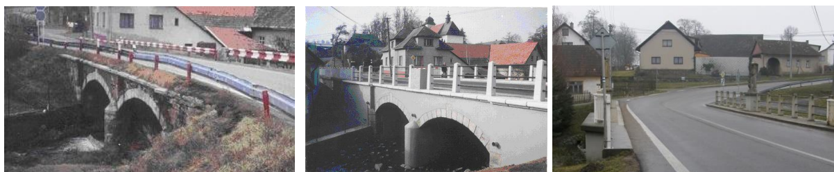
Obr. 10: Most před opravou Obr. 11: Pohled na čelo po opravě Obr. 12: Pohled po komunikaci
