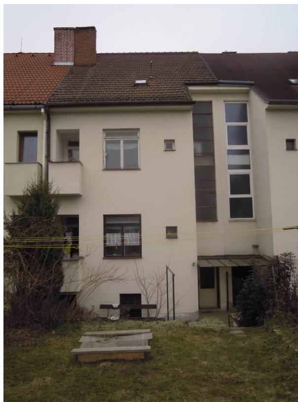
Obrázek 2.: Pohled ze dvora na dům před rekonstrukcí. ↑
