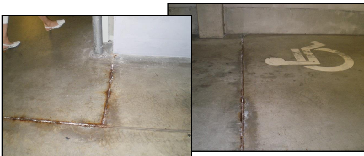
Obr.7 Typický stav ocelových prvků – použitých pro bednění pracovních spár drátkobetonové vrstvy podlahy se vsypem
