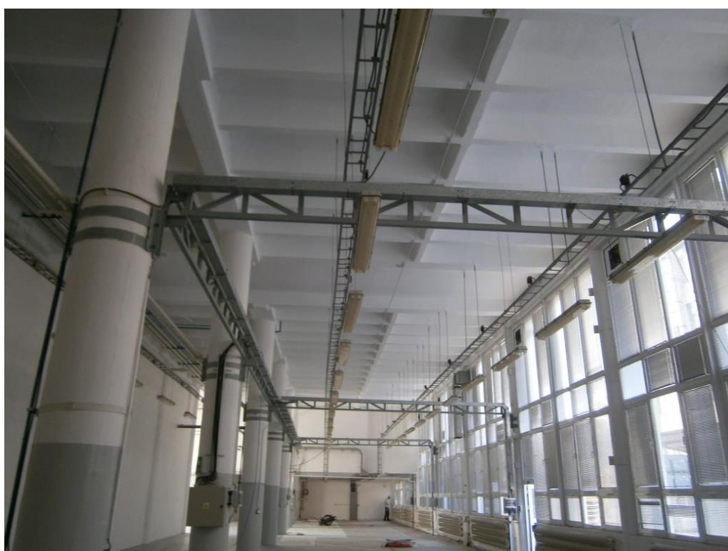
Obrázek 4.: Konstrukce po provedení sanace
