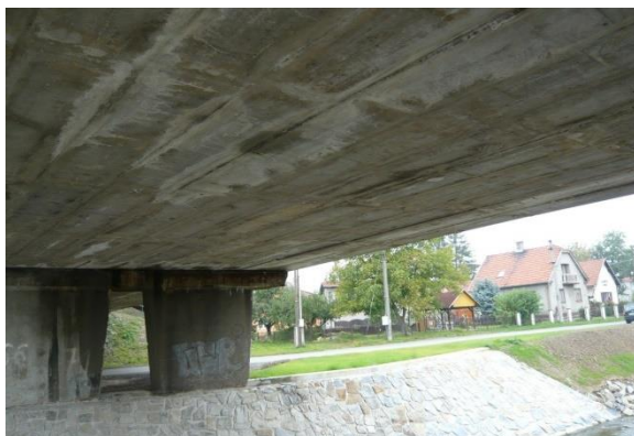
Obr.61: Podhled zamáčených korodujících nosníků KA
