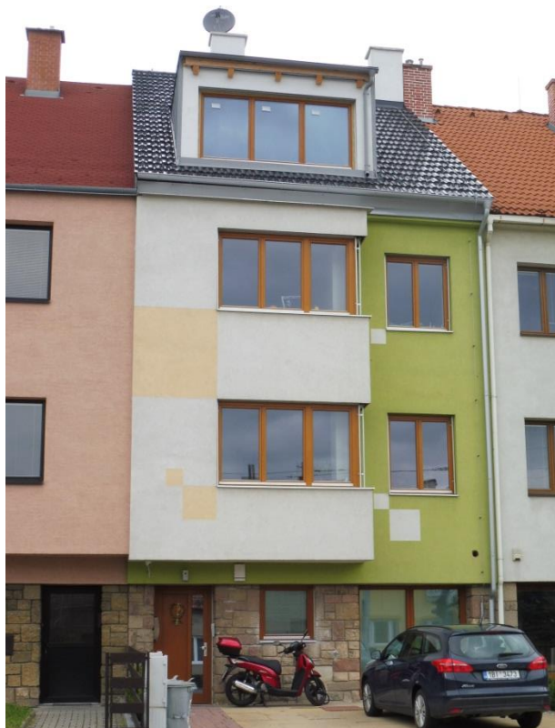
Obrázek 14.: Uliční část domu po dokončení rekonstrukce. ↑
