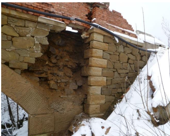
Obr.21: Pohled na kavernu před opravou
