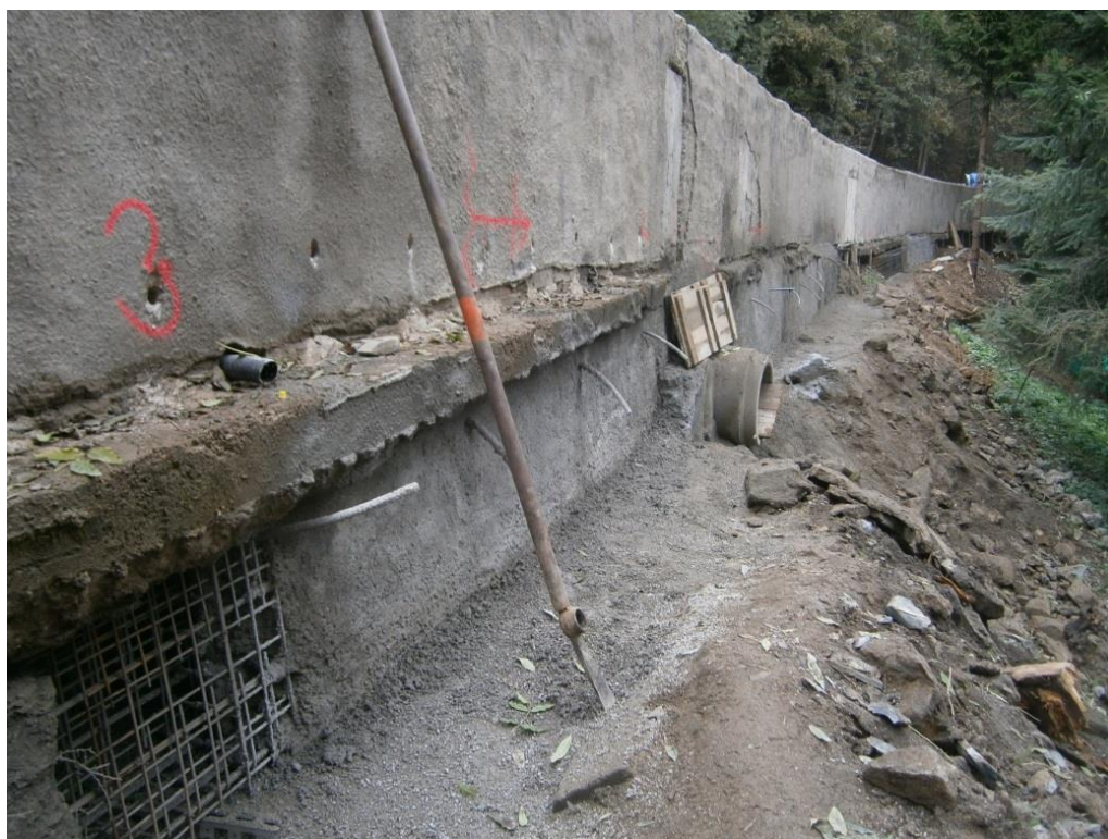
Obrázek 4.: Provádění zajištění základové spáry
