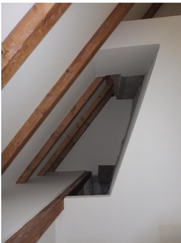
Obrázek 12.: Pohled na dokončené podkroví s viditelnými krokvemi. ←
