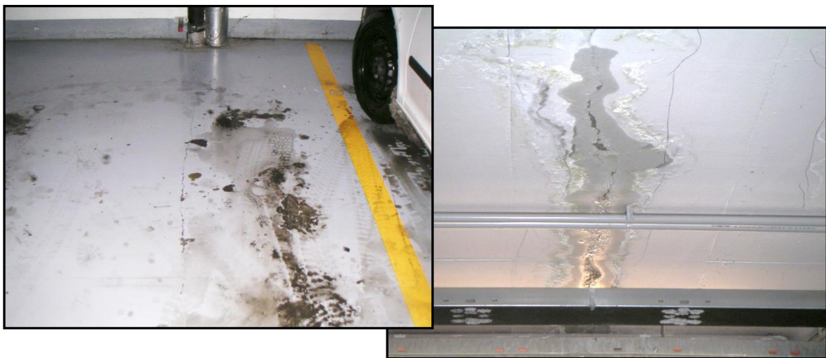
Obr.1: Typický zimní stav podlahy – mezistropu hromadných garáží; louže na podlaze, průsaky trhlinami na podhledu
