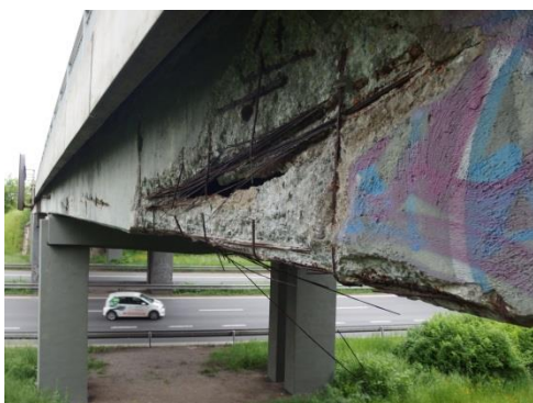
Obr.59: Nosníky KA-61-přezlé předpínací výztuž
