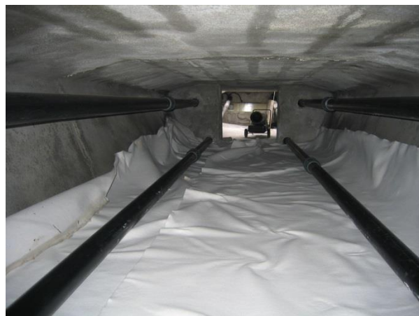
Obr.56: Volné kabely –sanace komorového mostu
