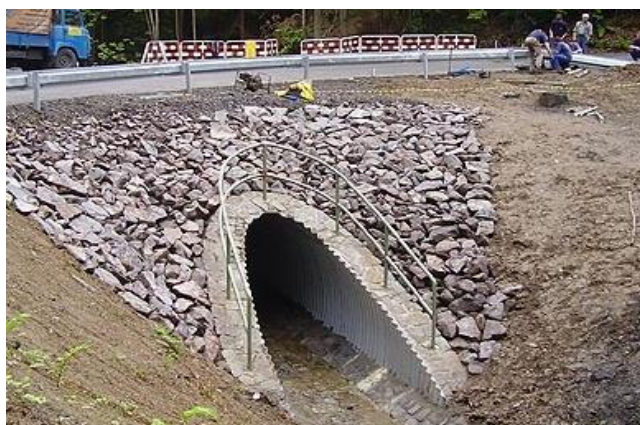
Obr. 27: Vkládání flexibilní k-ce do mostního otvoru Obr. 28: Dokončený most
