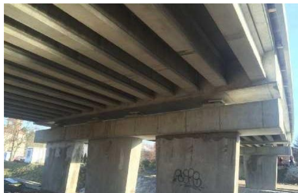
Obr.62: Nová NK – předpjaté prefa + spřažená žlb. deska
