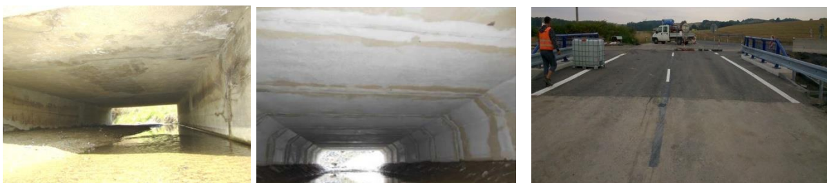
Obr. 65: Zamáčený, deskový most Obr. 66: Žlb. rámy typu „Beneš“ Obr.67: Pohled po vozovce
