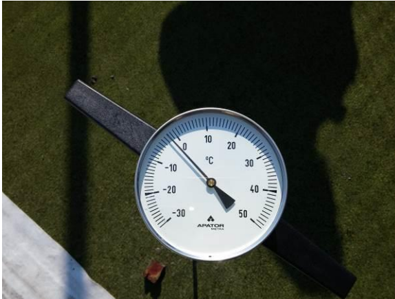
Obrázek 5: Pohled na měření teploty základové půdy na P8 – teploměr tyčový APATOR METRA Šumperk (v levém rohu dole – hadice mrazícího zařízení)
