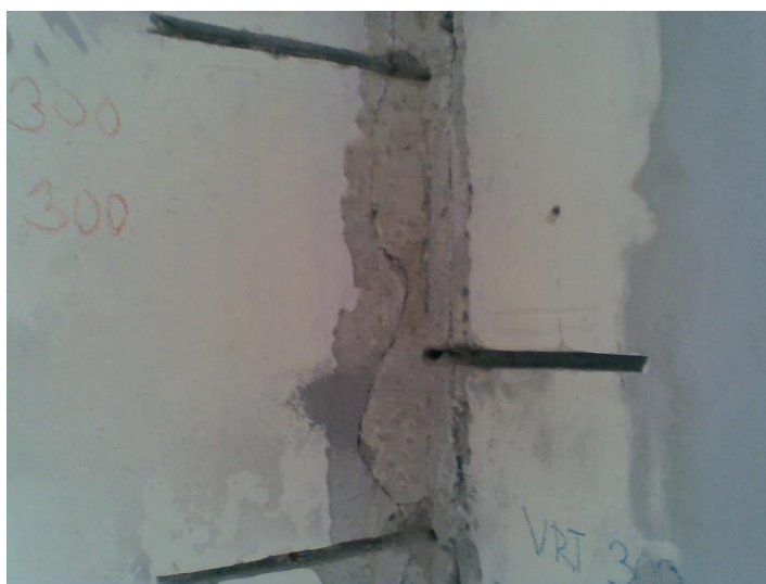
Obrázek 5.: Typická ukázka spoje vrt – drážka – spoj dvou na sebe kolmých panelů
