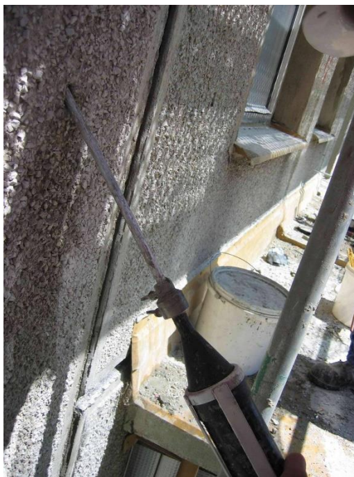
Obrázek 2.: Nejvhodnější aplikace přímých výztuží – přímo z aplikátoru zároveň s maltou
