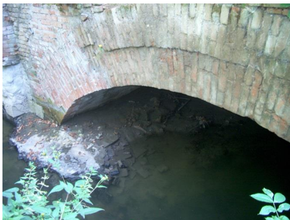
Obr. 20: Totéž místo po opravě
