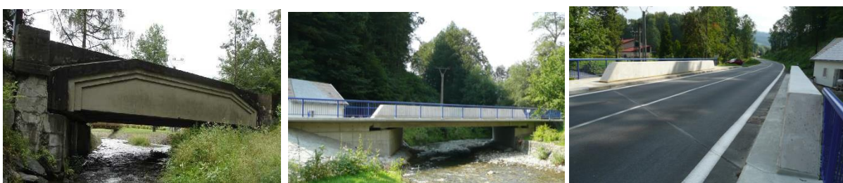
Obr. 71: Parapetní úzký a dožitý most Obr. 72: Nový parapet. s konzolou chodníku Obr. 73: Pohled po vozovce
