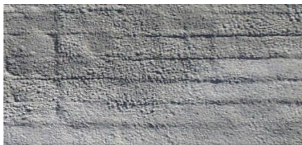
Obr. 34: Pohled na 1. vrstvu torkretu
