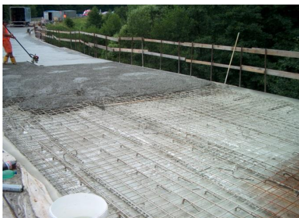
Obr.39: Betonáž spřahené desky
