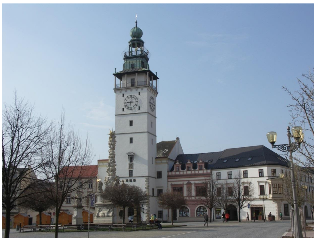
Obrázek 2.: Pohled na předpínáním stabilizovanou radnici ve Vyškově
