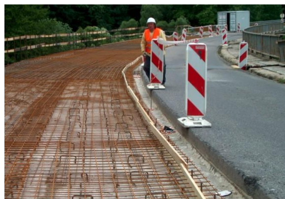
Obr. 38: Spřahovací prvky, výztuž KARI (oprava po ½)
