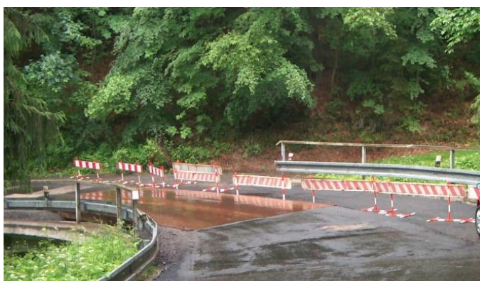
Obr. 26:Mostní ocelové deskové provizorium dl. 11 m
