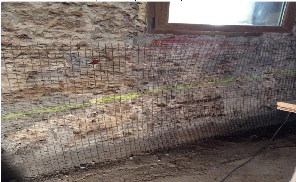
Technologický postup sanace: Očištění podkladu a proškrobání spár ve svislé kci
