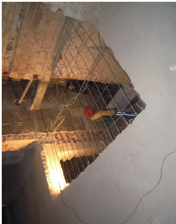
Obrázek 7.: Odbouraný světlík a část stávajícího trámového stropu nad 1.PP. ←
