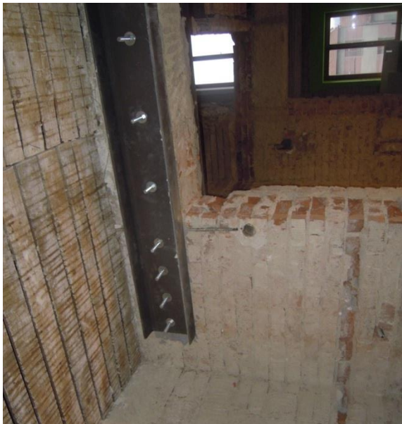
Obrázek 4.: Nové ostění pod zesíleným průvlakem – strana u komínového tělesa. ←
