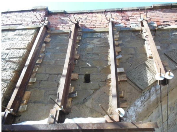
Obr.23: Pohled na kotvení na opačné (příčně) straně mostu
