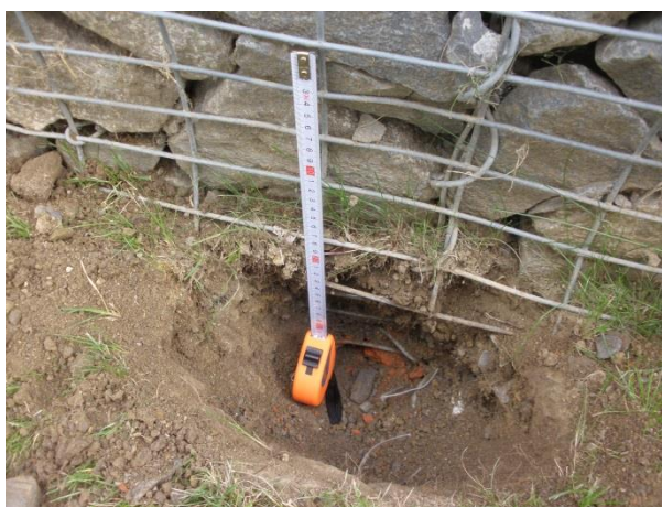
Obrázek 5.: Sonda S1 - gabiony položeny mělce na zeminu bez základu.
