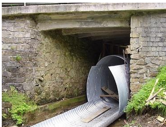
Obr. 27: Vkládání flexibilní k-ce do mostního otvoru Obr. 28: Dokončený most
