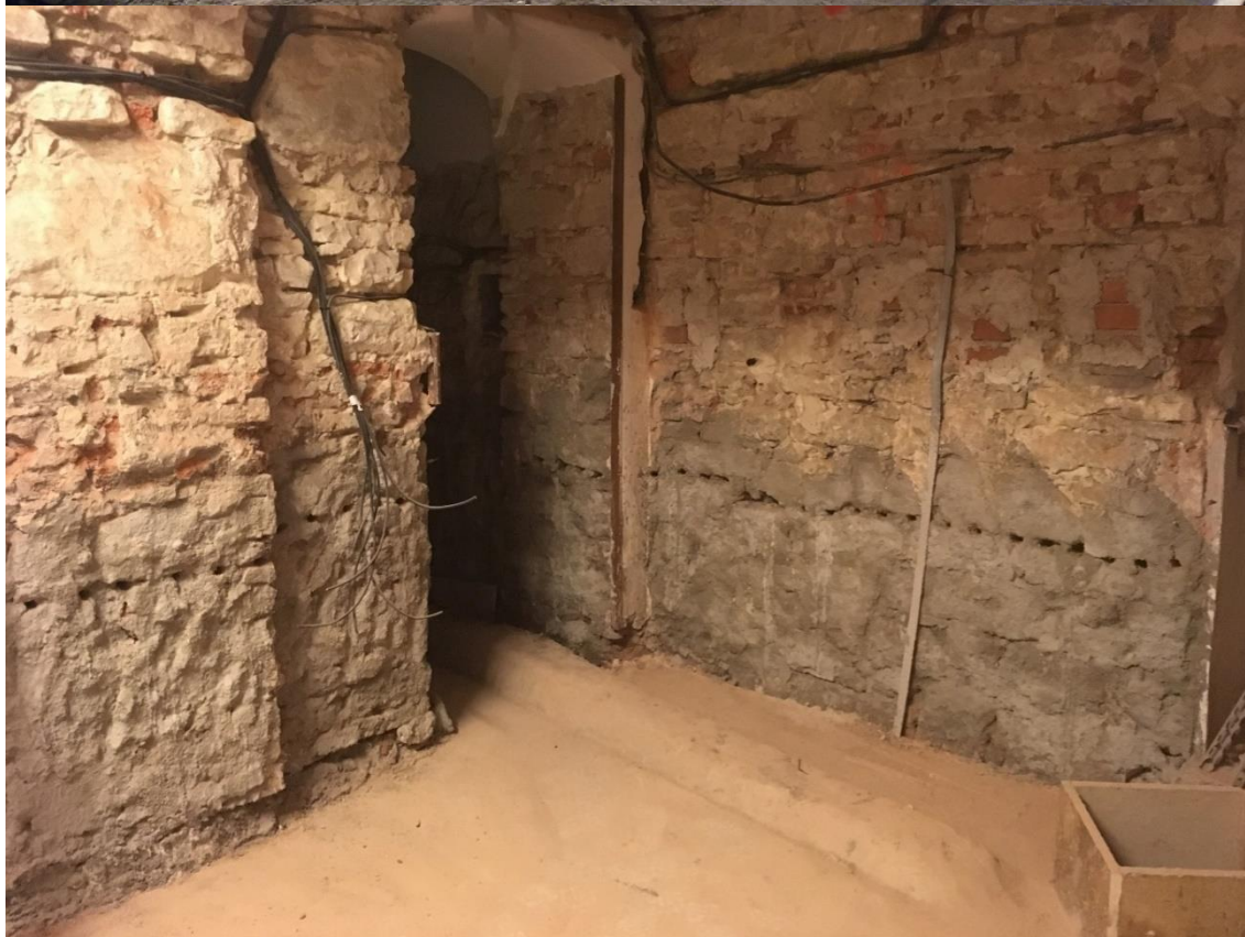
Provedení clony proti prostupu vlhkosti do úrovně 1.NP – Freeztecq
