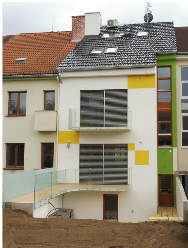
Obrázek 15.: Zahradní část domu po dokončení rekonstrukce. ↑
