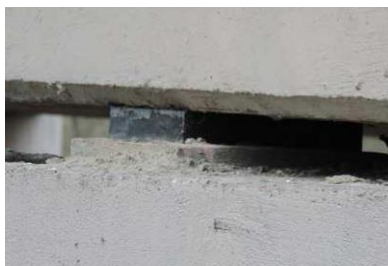
Obr. 46: Nové ložisko
