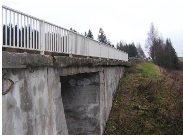
Obr.35: Stav mostu před sanací
