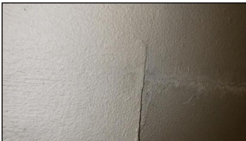
Obr.2: Prokreslování poruch na opakovaně přemalovávaném pohledu stropu
