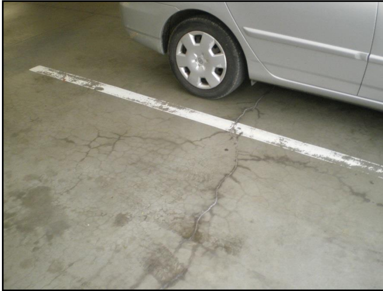
Obr.8 Příklad charakteristického stavu rozvoje trhlin na pojížděném povrchu drátkobetonové podlahy garáží
