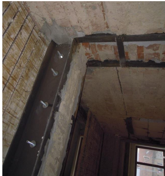
Obrázek 5.: Nové ostění pod zesíleným průvlakem – strana u schodišťové stěny. ←
