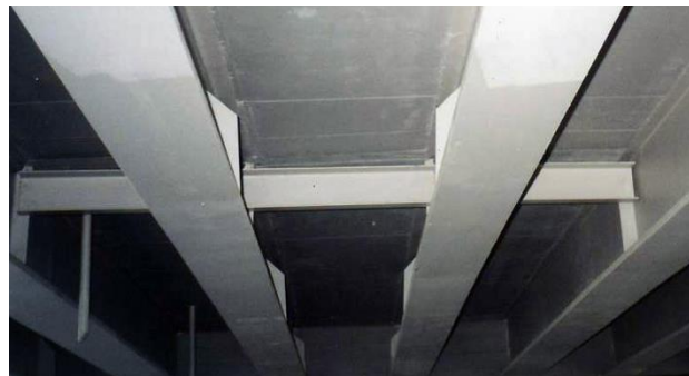
Obr.64- detail hl. nosníku, příčnicku a spřažené desky
