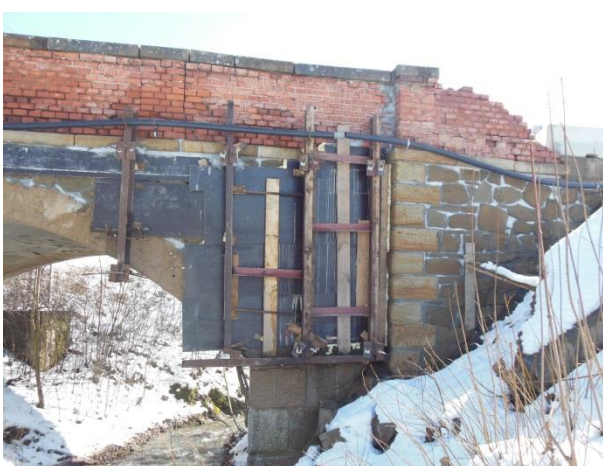
Obr. 22: Totéž místo po opravě
