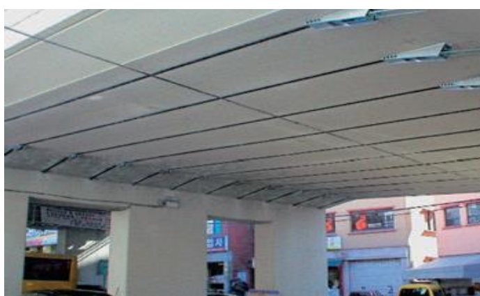
Obr. 54: Předpjaté uhlíkové lamely
