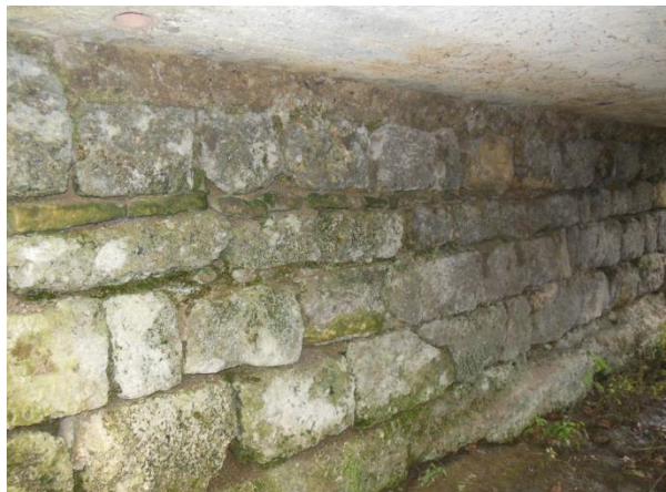
Obr. 2: Kamenná opěra, NK betonová deska
