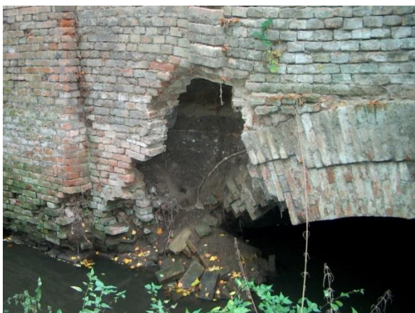
Obr.19: Pohled na vtok po havárii
