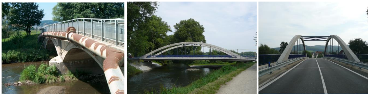
Obr. 77: Úzký dožitý – 2 klenby Obr. 78: Betonový Langerův trám Obr. 79: Pohled po vozovce
