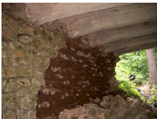
Obr.25: Pohled na opěru po havárii
