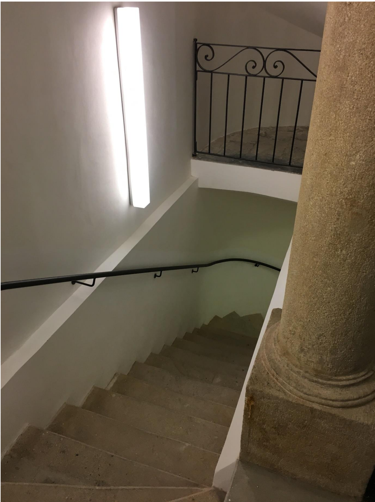
V úrovni 1 NP ošetření klenby proti vztlínající vlhkosti ve formě krému Polaris Aplikace vodotěsné omítky Waterfix XP TH na svislou kci v úrovni „0“ Hydroizolace nad klenbou polymercementovou stěrkou Waterfin PV
