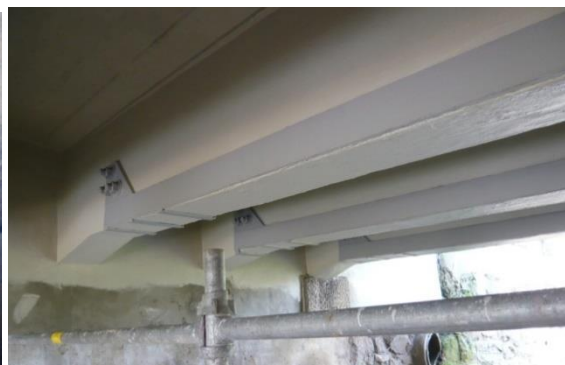
Obr. 52: Externí ocelová výztuž na trámové k-ci
