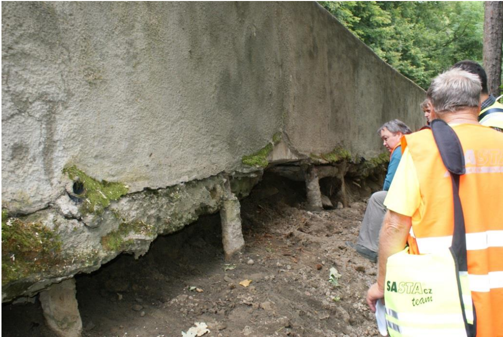
Obrázek 2.: Původní stav konstrukce, poškozený základ, obnažené mikropiloty
