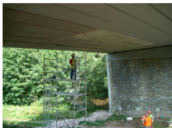
Obr. 42: Aplikace ochranného nátěru
