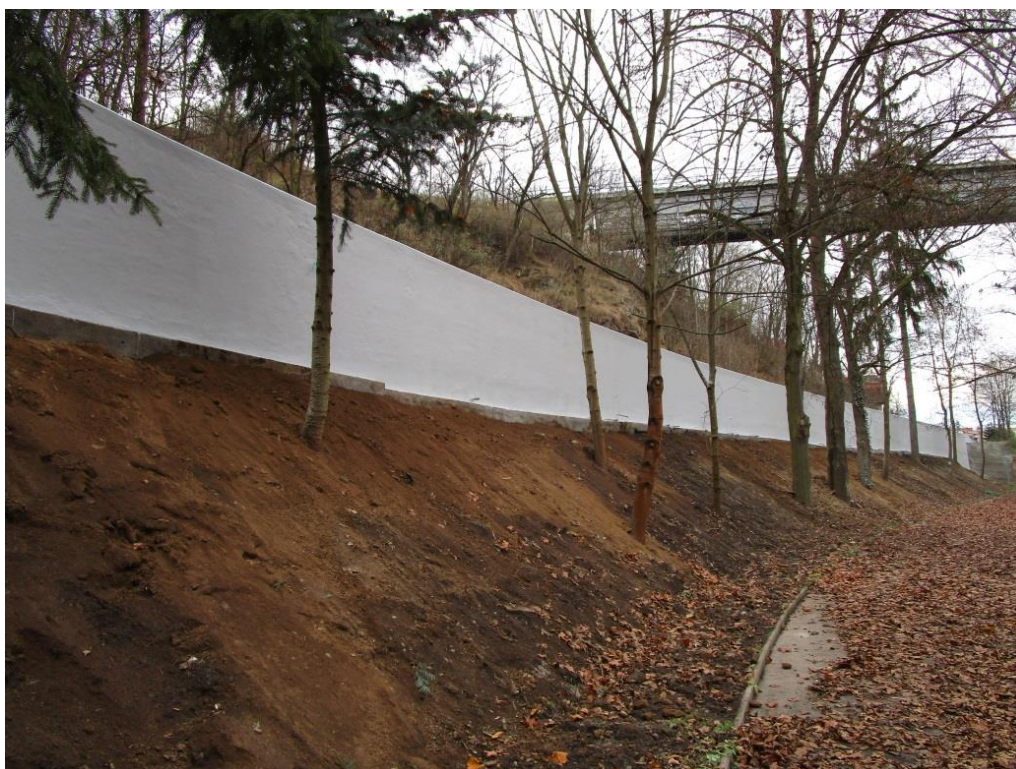
Obrázek 7.: Pohled na dokončenou stěnu
