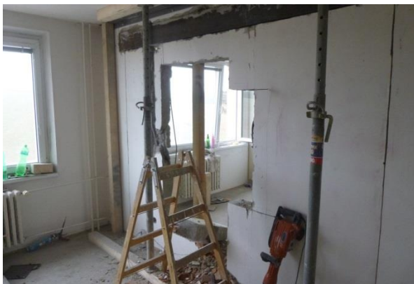
Obrázek 5.: Příprava a bourání nového otvoru
