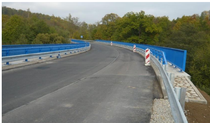
Obr.43: Stav svršku po sanaci
