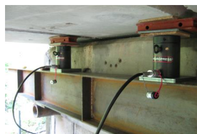
Obr. 47: Zvedání z líce opěry
